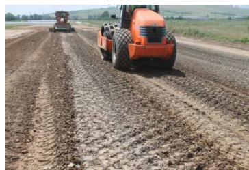
Fig. 13. Compactarea amestecului pământ – liant rutier
