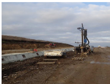
Fig. 4. Execuție foraj cu instalația de foraj Hydra Joy 3
