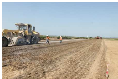
Fig. 12. Amestecarea liantului rutier cu solul existent/pământ umpluturi
