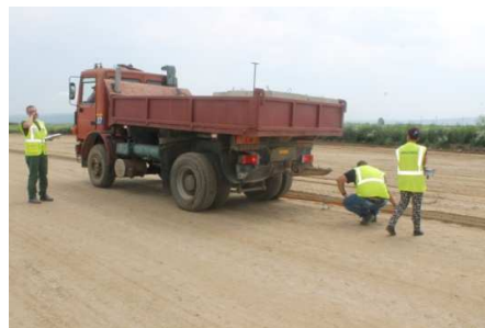
Fig. 7. Încercare în teren efectuată cu deflectometrul cu pârghie Benkelman
